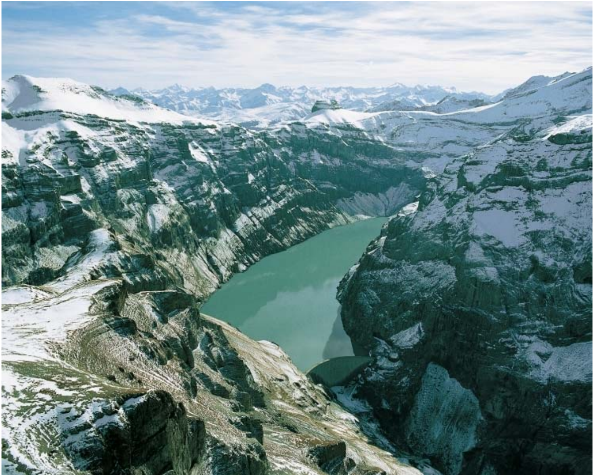
Blick auf Limmernsee und Alpen: Die neuen Kraftwerksanlagen kommen grösstenteils unterirdisch zu liegen. (Quelle Axpo AG)
